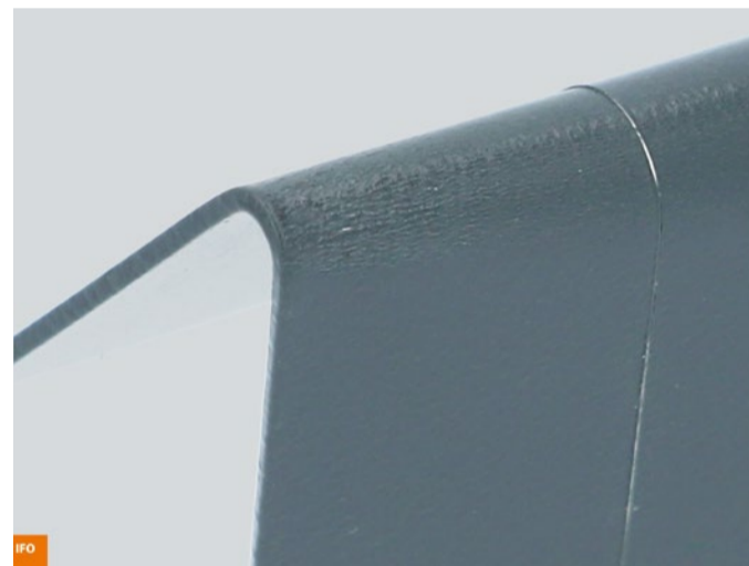
Nach einem Biegeversuch ist am beschichteten Blech zu klären, ob es sich um Dehnungsstreifen oder Risse handelt.
