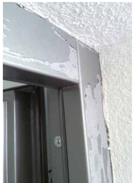
Großflächige Enthaltungen nach dem Ablösen des Klebebandes, bedingt durch Vorschädigungen der Oberfläche.
